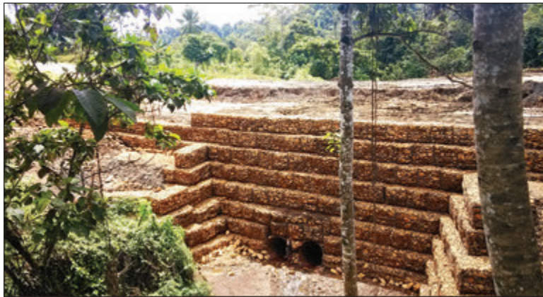
Stat bilong wok we Ramu NiCo yusim masin bilong en yet long stretim rot bagarap long Iguruwe long Madang-Lae haiwe. Foto: James G. Kila
