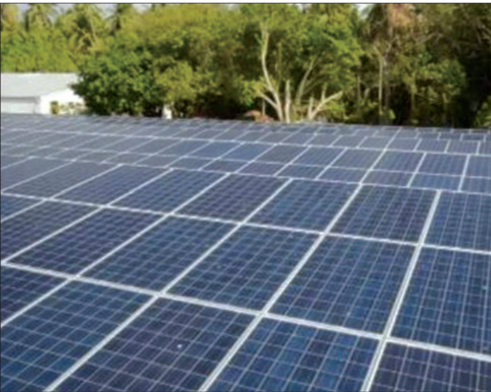
Ol solar panel long Tonga. Poto na stori: ABC
