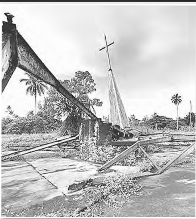
HAUS LOTU IBAGARAP: Ples we Katolik haus lotu long Torokina i bin sanap long en. Ol i kisim piksa wanpela de pastaim ol lain bilong sip HMAS Choules i statim wok long klinap na stretim.
