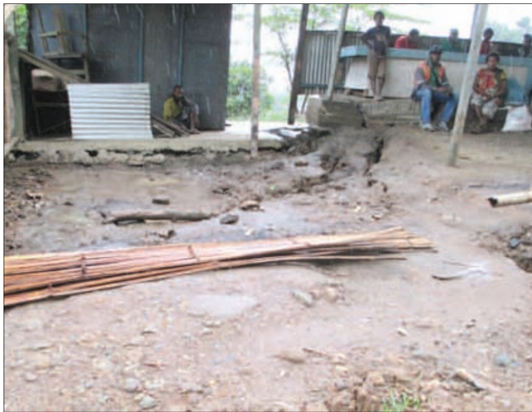
Graun bruk na simen long haus-maket tu i bruk long Kawawar maket long Madang-Ramu Haiwe.
