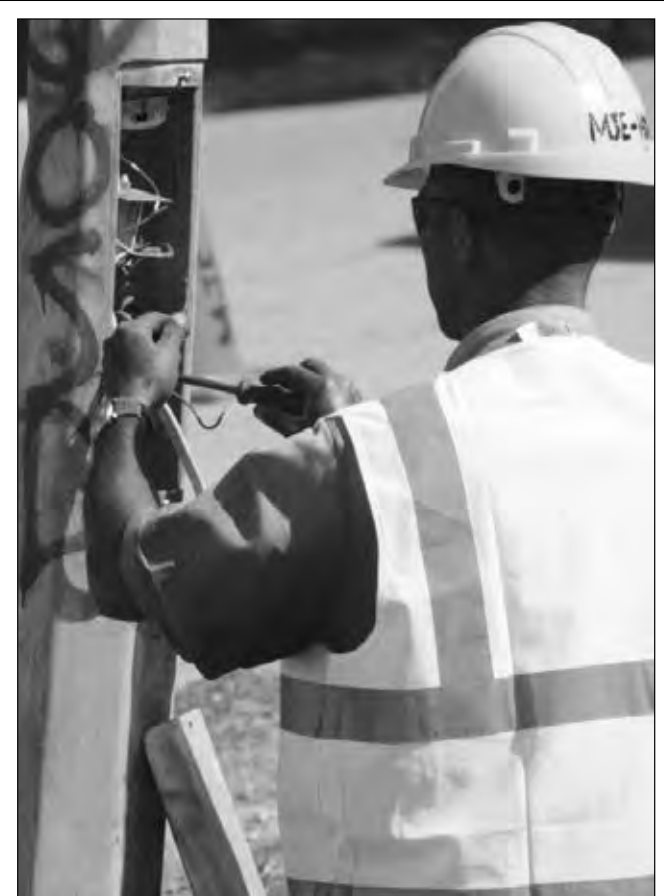
STRETIM WAIA: Ol wokman bilong MJ Electronics, wanpela elektrik kampani i holim kontrak wantaim Nesenel Kapitèl Distrik Komisn i wok senisim ol strit lait long Gerehu i kam long Yunivesiti bilong PNG. Dispela man i sindaun long as bilong ol longpela pos na stretim ol waia bilong lait. Poto: Nicky Bernard
