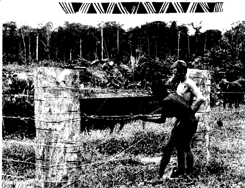
Em i pasin bilong taitim waia bilong banis. Sampel save taitim wanpela waia tasol na putim lektrik insa
